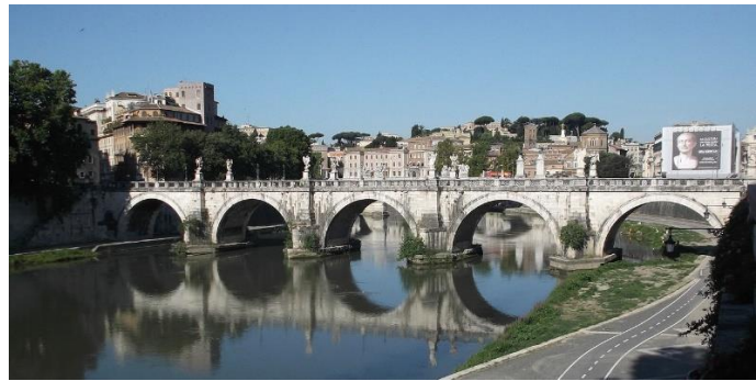
fig. 2 – Ponte Bridge Sant'Angelo (D'Afflitto)
